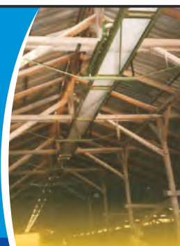
Csarnokrendszerű magtár feltöltése BET-375 típusú betárolószalaggal 40 tonna/óra, lekotrókeke nincs, túlhordás nincs.
