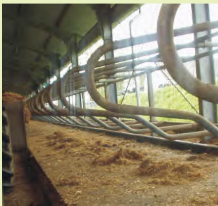
3. ábra: A lehúzott függönnyel nyitott vált oldalfalon át friss levegő-, fény-, napsütés juthat az istállóba, közvetlenül a függöny melletti pihenőboksokba. Nyitott oldalfal előnyei: friss levegő, fény, napsütés. Hátrányai: beverhet az eső, hófúvás az istállóban, metsző fagyos szél
