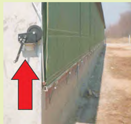
5. ábra: Istállón kívül, a homlokfalon elhelyezett kézi forgató mechanizmus, az oldalfalat helyettesítő függöny mozgatásához (nyitáshoz, zárásához)
