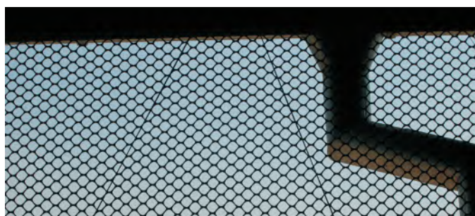
2. ábra: Az oldalfalat helyettesítő függönyrendszer része lehet a madárvédő háló, melyet az odalfalnyílásba feszítenek ki, a ponyva anyagból készített függönnyel párhuzamosan. A madárvédő háló jelentősen korlátozza az istálló légcseréjét.
