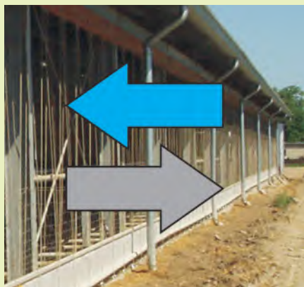
4. ábra: A lehúzott függönnyel szabaddá tett oldalfal felületen a légcserét, az épület tartó szerkezete, az esővíz-elvezető, csövek, állatkorlátok, mint „természetes szerkezeti anyagok”, is korlátozzák
