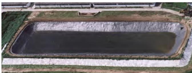
Nyitott földmedrű tározó kialakítása, Bátaszék cca. 10000 m 3
