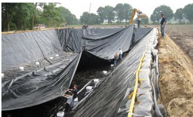
Fedett földmedrű tározó kialakítása
