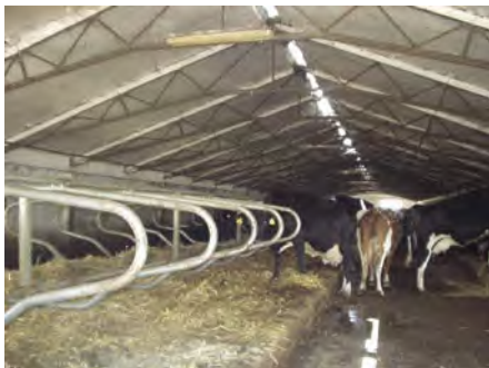
1. ábra: Többször átalakított, hőszigetelt pihenőbokszos tehenistálló nyitott tetőgerinccel, mennyezet nélkül, hőszigetelt nyereg-tetőzettel, hőszigetelt oldalfallal, beton padozattal.
