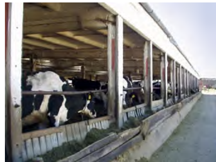
3. ábra: Többször átalakított, lapos tetős, pihenőbokszos tehenistálló, hőszigetelt lapos tetőben szellőző nyílásokkal, bonított hőszigetelt oldalfalban kialakított fa jásszal, világos kis fajlagos légterrel, kis fajlagos alapterülettel.
