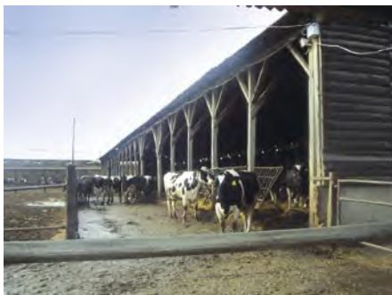
4. ábra: Egy oldalon nyitott falú, hőszigetetlen tehenistálló pózna oszlopokon, mennyezet nélkül, hőszigetetlen nyereg-tetővel, három oldalfalán hőszigetetlen zárt faburkolattal, döngölt agyag padozattal.
