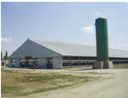
5. ábra: Két oldalon nyitható-zárható oldalfalú új tehenistálló fém oszlopokon, mennyezet nélküli hőszigetetlen nyereg-tetővel, a gerincen végig futó állandó gerincnyílással
