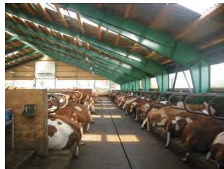
6. ábra: Két hosszanti oldalán nyitható-zárható oldalfalú új tehenistálló fénybeeresztő tetőfelületekkel, matracos pihenőbokszoakkal, beépített trágyael-távolítóval, fűthető hőfokszabályozós önitatókkal, beton padozattal.
