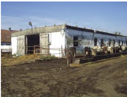
2. ábra: Átalakított, hőszigetelt, lapos tetős tehenistálló zárt és hőszigetelt tetővel, hőszigetelt oldalfalakkal, nyitható ablakkal, külső fedetlen etetőtérrel, kifelé nyíló ajtókkal, döngölt agyag padozattal.
