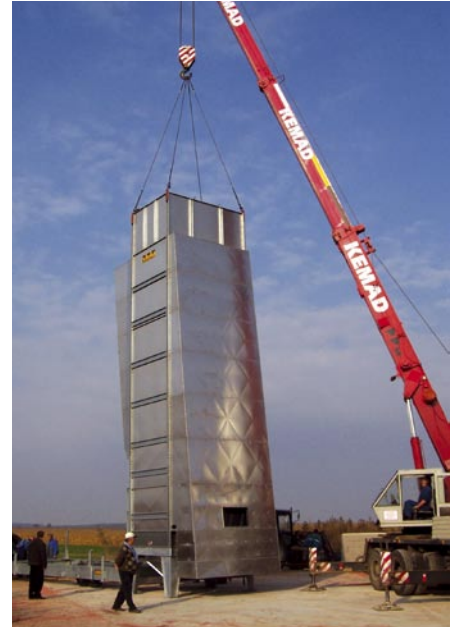
Szárítóberendezés alaptestre emelése
