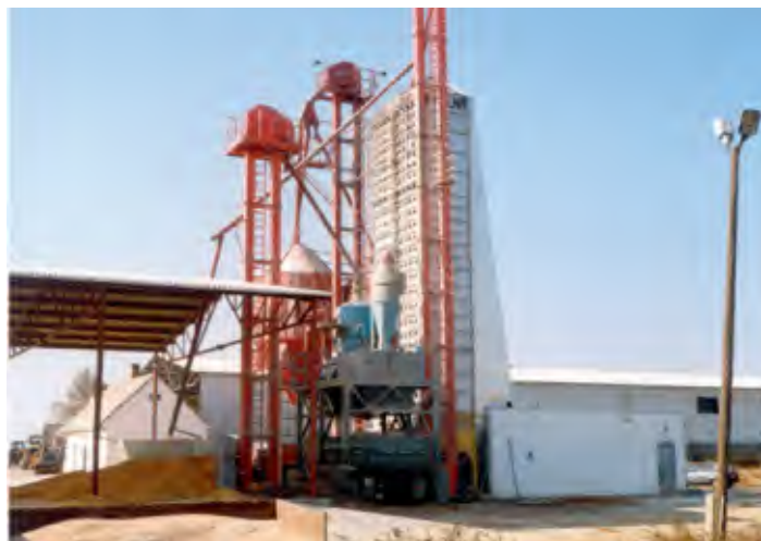
▲ Újkori állapotú B1-15 szemes terményszárítóra alapozott telep (1990-es években épült)
