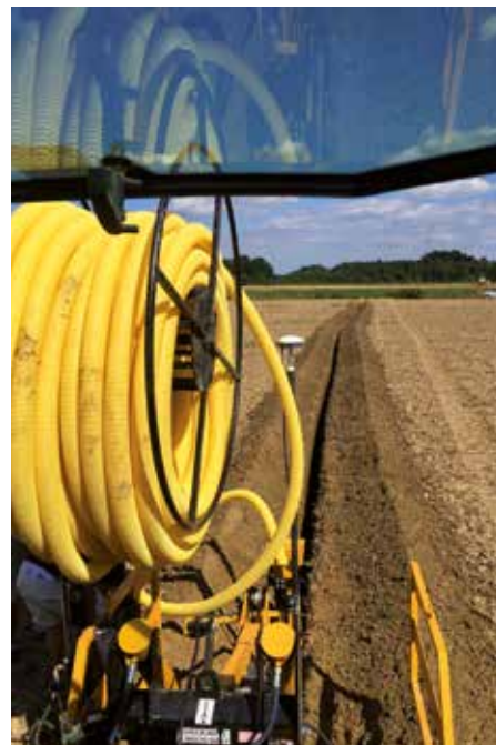
4. kép Drén csövek lehelyezése
