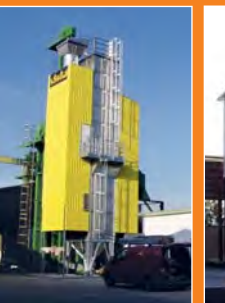
Dunavecse • MDB-TN-1/8-S, 10 t/h Skandia szállítógépek
