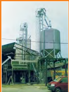
Mezőfalva • MDB-TN-1/10-SU, 15 t/h Westrup tisztító, Skandia szállítógépek, Symaga silók
