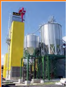
Mezőfalva • MDB-TN-1/10-SU, 15 t/h Westrup tisztító, Skandia szállítógépek, Symaga silók
