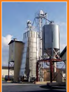
Medgyesbodzás • Universal-25, 10 t/h, Marot tisztító, Skandia szállítógépek, Symaga silók
