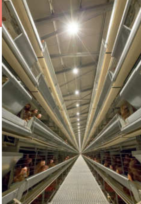
▲ Magyarország legnagyobb tojótyúk istállója, 100 ezer tyúk, 8 szinten. Az alsó szinteken is biztosított az EU előírás szerinti homogén 20 Lux megvilágítási érték, napfelkelte-napnyugta szimuláció. Az automata világítási rendszer összteljesítménye 2800 Watt
