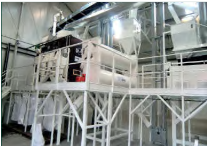
▲ Ügyfélre szabott megoldások Kamuton. Élelmi mag feldolgozó üzem, 6 t/h kapacitással. A beruházás idén Cimbria terményszárítóval egészült ki
