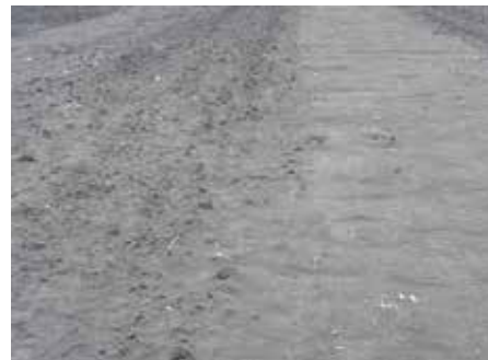
3. kép: leiszapolódott felszín a korszerűtlen gerendasimító munkáját követően (Fotó: Dr. Bottlik, 2019)
