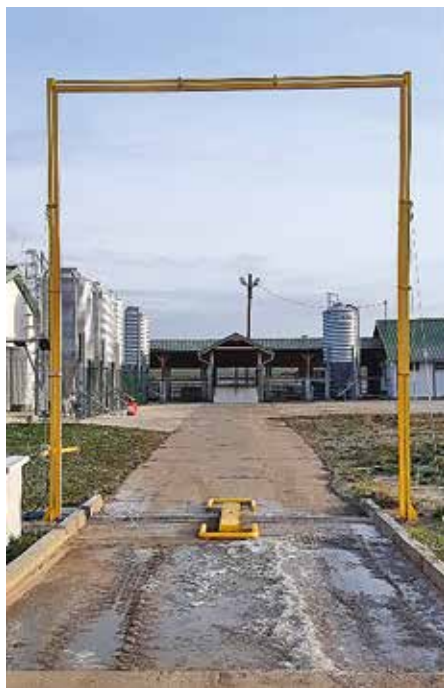
Járműfertőtlenítő kapu és járműfertőtlenítő medence kombinációja
