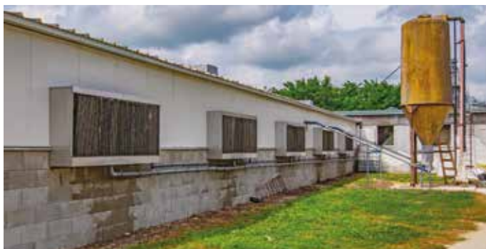
Használatban lévő hűtőpanelek, tisztításra várva
